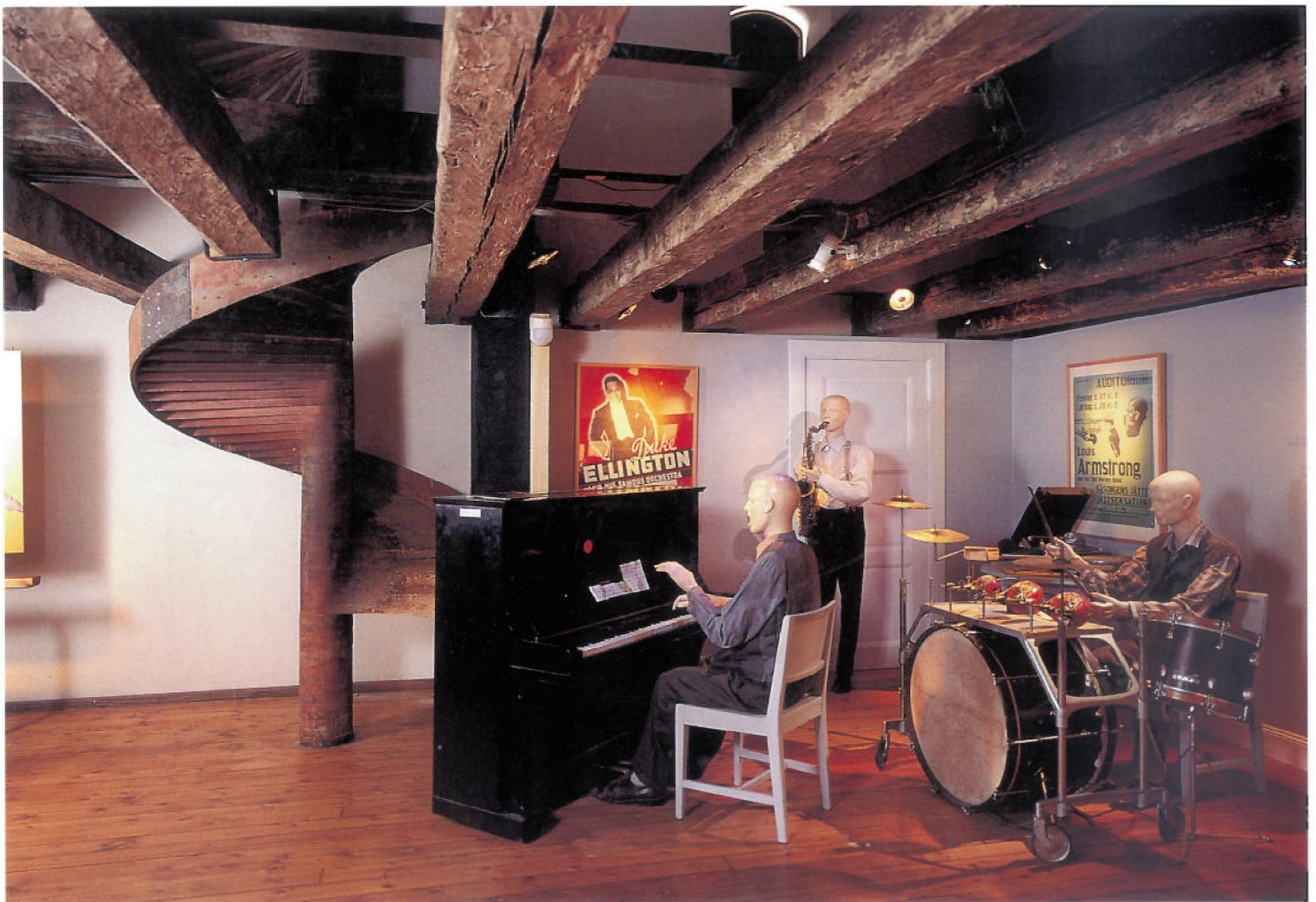
Få detaljer i interiören minner i dag om bageriets 300-åriga historia. I en av utställningssalarna har dock en träutschbana för mjölsäckar bevarats till våra dagar.
